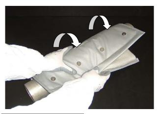
WRAP THE BLANKET AROUND THE PIPE (PART). FORM AND COMPRESS THE BLANKET WHILE WORKING TO CLOSE THE SEAM.
