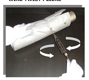
BE SURE TO OVERLAP THE SEAM WITH THE FLAP. THE INSULATION SHOULD MEET AND FORM A COMPLETE LAYER AROUND THE PART.
